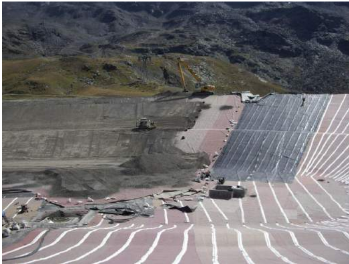
Mise en œuvre au bobcat avec sollicitations dynamiques
