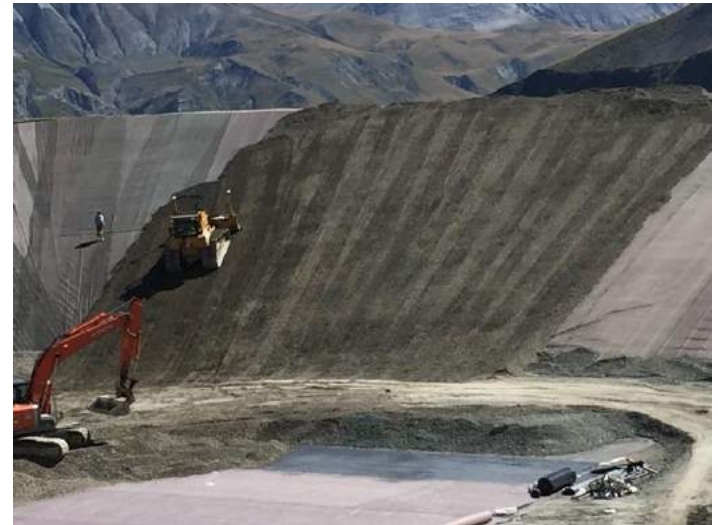
Mise en œuvre au bull D6 avec sollicitations dynamiques
